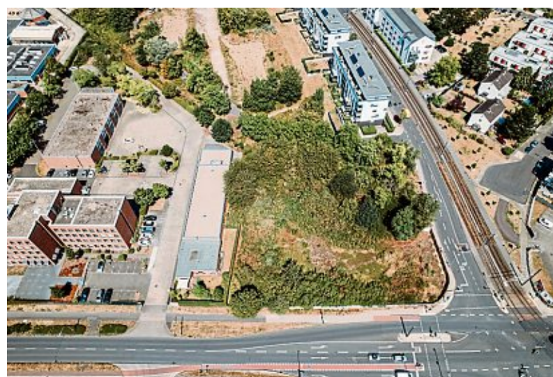
Das Baufeld an der Fitzmauricestraße
